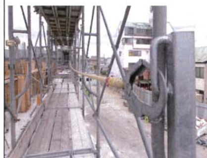
親網緊張状況・親網支柱取付け緊張完了
