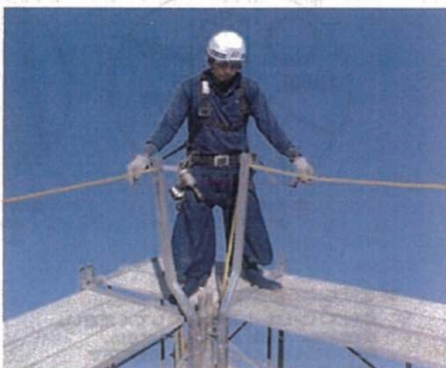
コーナー部にて安全帯のフックを取付け
