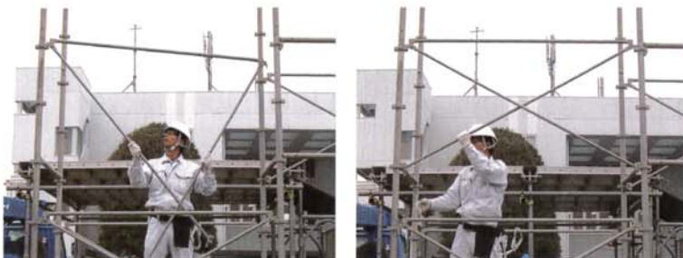
先行手すり、筋交い、二段手すりの機能を兼ね備え、「安全性」と「施工性」が向上!
