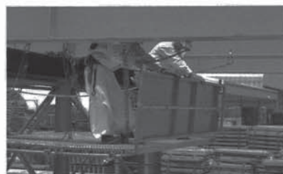
設置パネルに取付けているチェーンを持ちスパイダーパネルを前に倒し取り付ける
