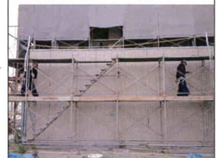
親網支柱取付け緊張完了状況
