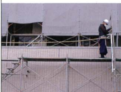
上部組立作業状況
