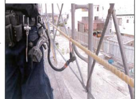
親網支柱・安全带取付け状況
