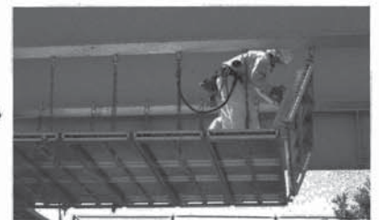
設置パネルに取付けているチェーンを持ちスパイダーパネルを前に倒し取り付ける
