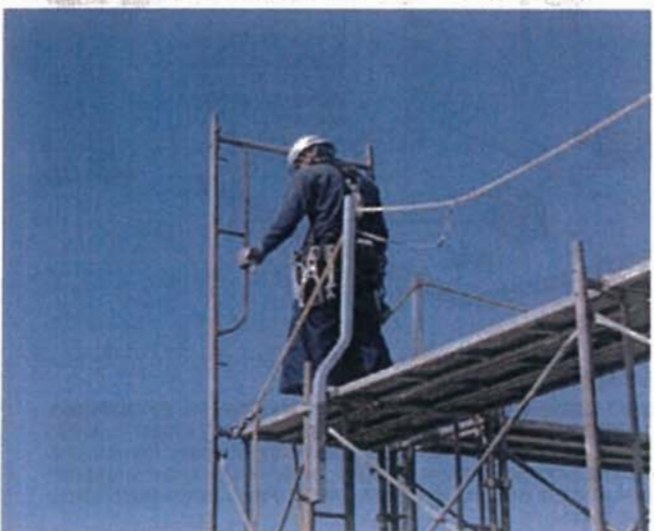
設置後、安全に組立作業 (1)
