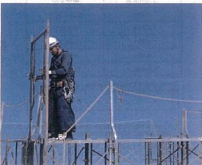
設置後、安全に組立作業 (2)
