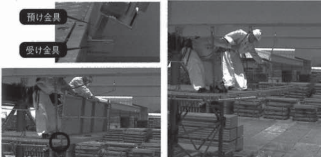
位置決めからのパネルの取付
